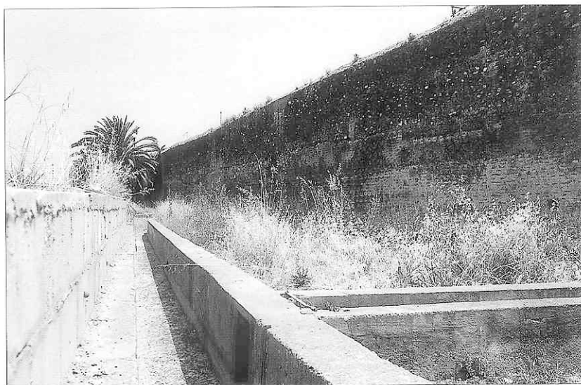
Llenç del costat del portal de Nules. A la fotografia pot comprovar-se la minva d'alçada de les muralles que va representar el cobriment de la séquia Major de Nules. (f.: V. Felip).
